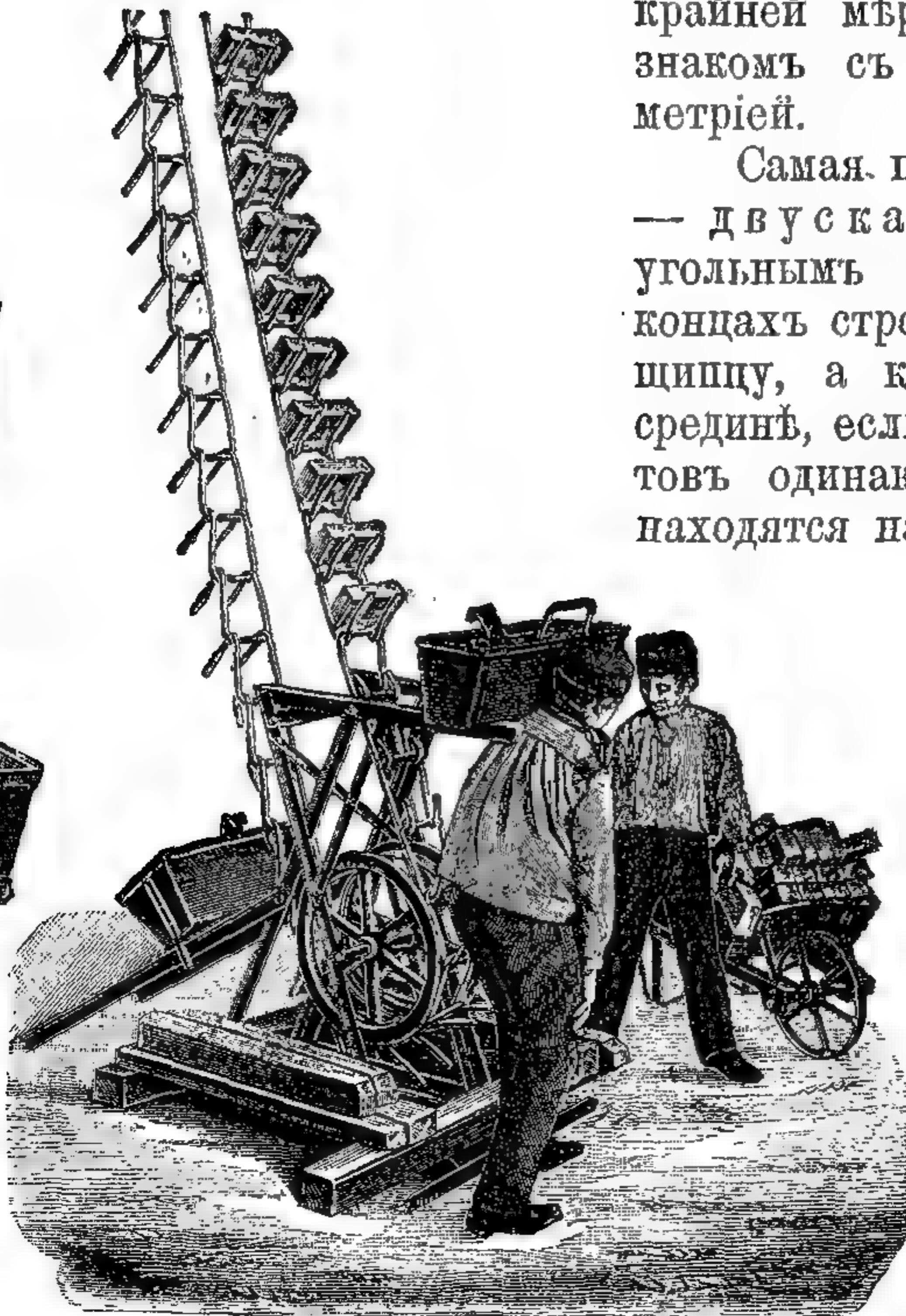
30. Элеваторъ для строит. матеріаловъ, завода Гауз, Гокнель и Ко. а цѣпь для подачи кирпича, б ящики для раствора, с ведро для воды или раствора.
